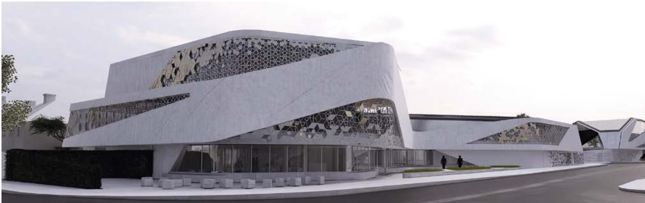
萨拉姆中心的突破性设计将使其成为北哈罗街区的标志之一, 尤其是其壮观的白色外墙, 该外墙的设计将采用 Krion® Lux 1100 坚硬表面材料, 并使用 Butech 的 K-Bolt 工业化隐藏式锚固系统。
