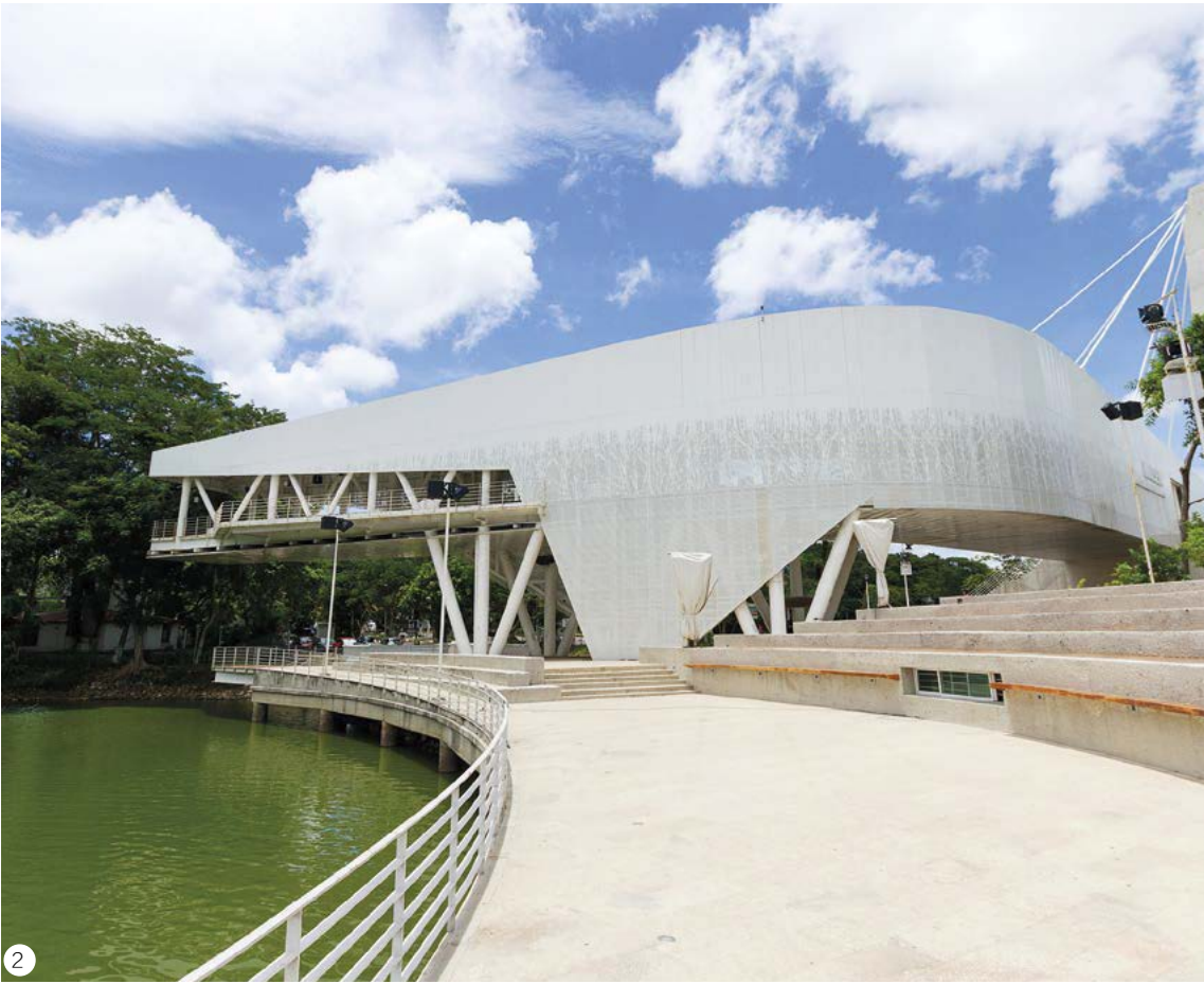
1. Torre Bancomer. 这座壮观的摩天大楼（235米）是BBVA墨西哥分行的总部。照片：Andres Virviescas 2. Musevi（比亚埃尔莫萨高架博物馆）。 坐落于塔瓦斯科州的比亚埃尔莫萨，用以庆祝墨西哥独立200周年。照片：Abalcazar 3. Mercedes House. 位于纽约最排外的区域之一（地狱厨房区）的豪华多功能公寓大厦。照片：Francois-Roux 4和5. 乔波大学博物馆。 这些追求光明的开放空间显示了墨西哥城这个文化交流中心的身份。照片：View Pictures
