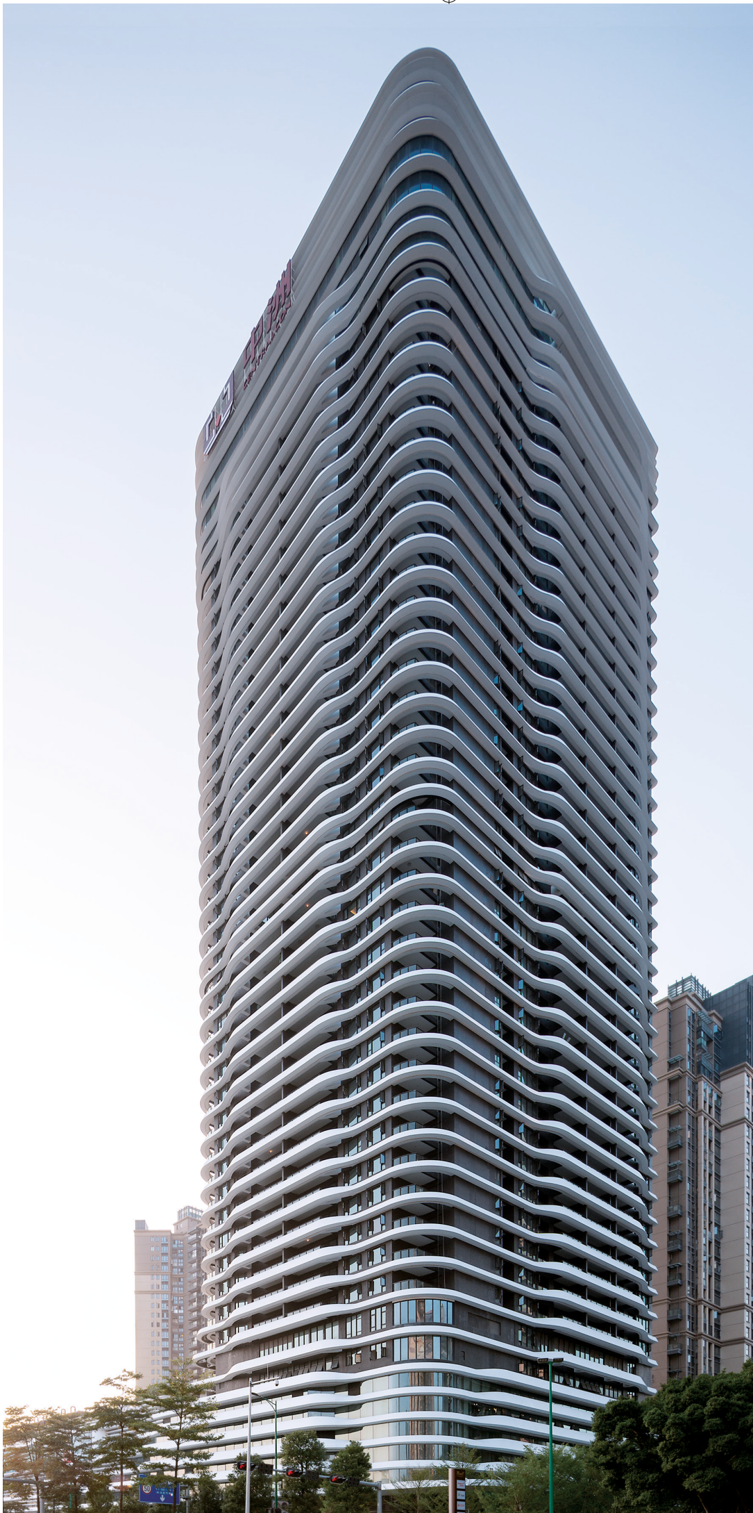
这座高达160米的宏伟建筑可一览深圳市貌，通风外墙采用 Krion®Solid Surface 材料，运用 K-FIX 系统建造，整个建筑面积近30000平方米。
