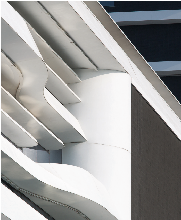
建筑夜景，显示其作为购物休闲中心的活力。 通风外墙的细节， Porcelanosa 旗下 Krion® Solid Surface 材料 让建筑设计变为现实。
