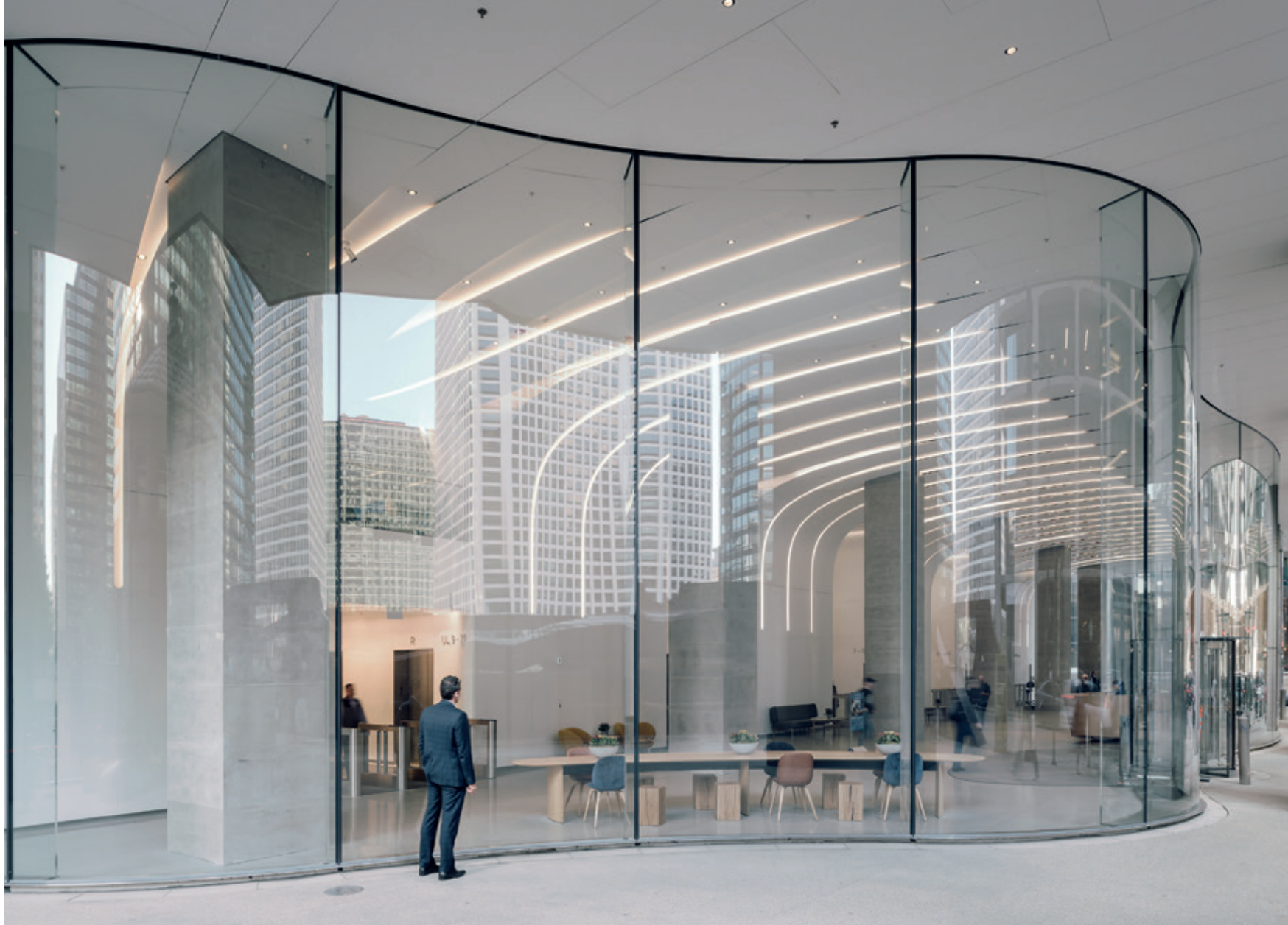
墙壁和屋顶共使用2000块 Krion® K·Life 板材， 此外还对建筑新式正面的玻 璃幕墙起到支撑作用。
